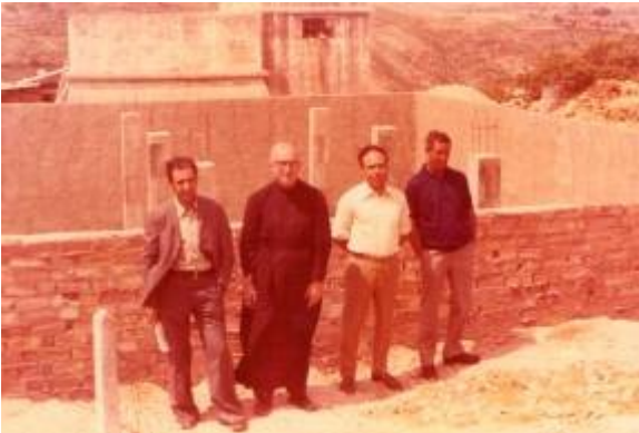
Construint el depòsit d'aigua
