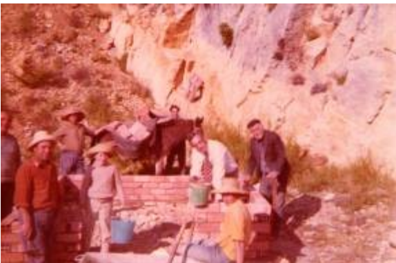
Construint l'ermita de la Mare de Déu de la Serra
